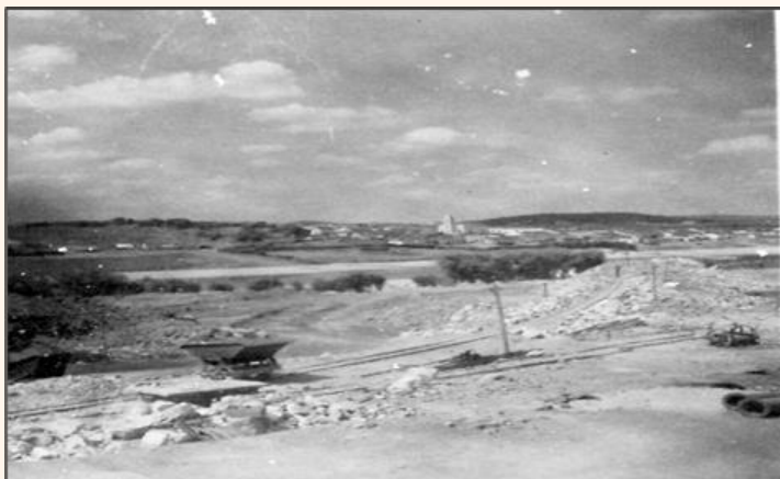
Fig. 1: Fotografia das obras da linhas férreas no Nordeste, entre os anos 1950 e 1960.
