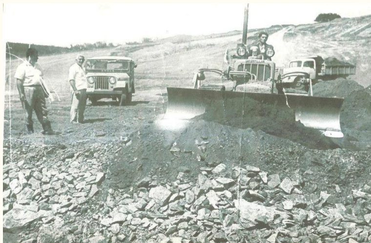
Foto 02: Construção do açude de Francisco Germano de Araújo pelo governo estadual de José Américo na década de 1950.
