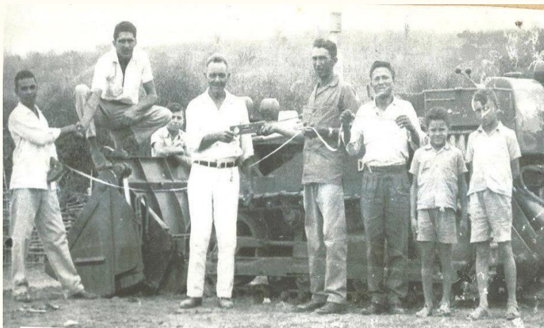
Foto 01: Construção do açude de Francisco Germano de Araújo pelo governo estadual de José Américo na década de 1950.
